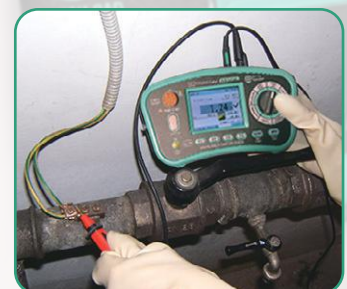
Continuity check of equipotential bonding
